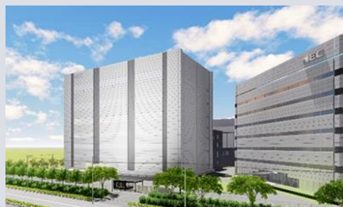
NEC神戸データセンター（三期棟）
