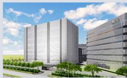
NEC神戸データセンター（三期棟）
