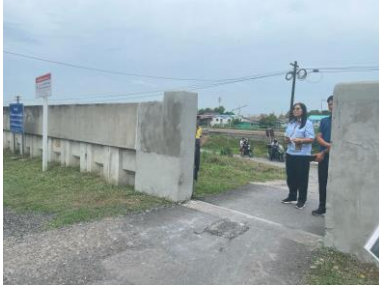
図 28：工業団地での洪水対策（止水版設置箇所と排水ポンプ）
